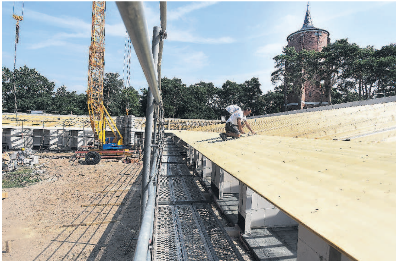
Spendenfinanziert: Für rund 3,6 Millionen Euro entsteht am Jügesheimer Wasserturm das Hospiz.
