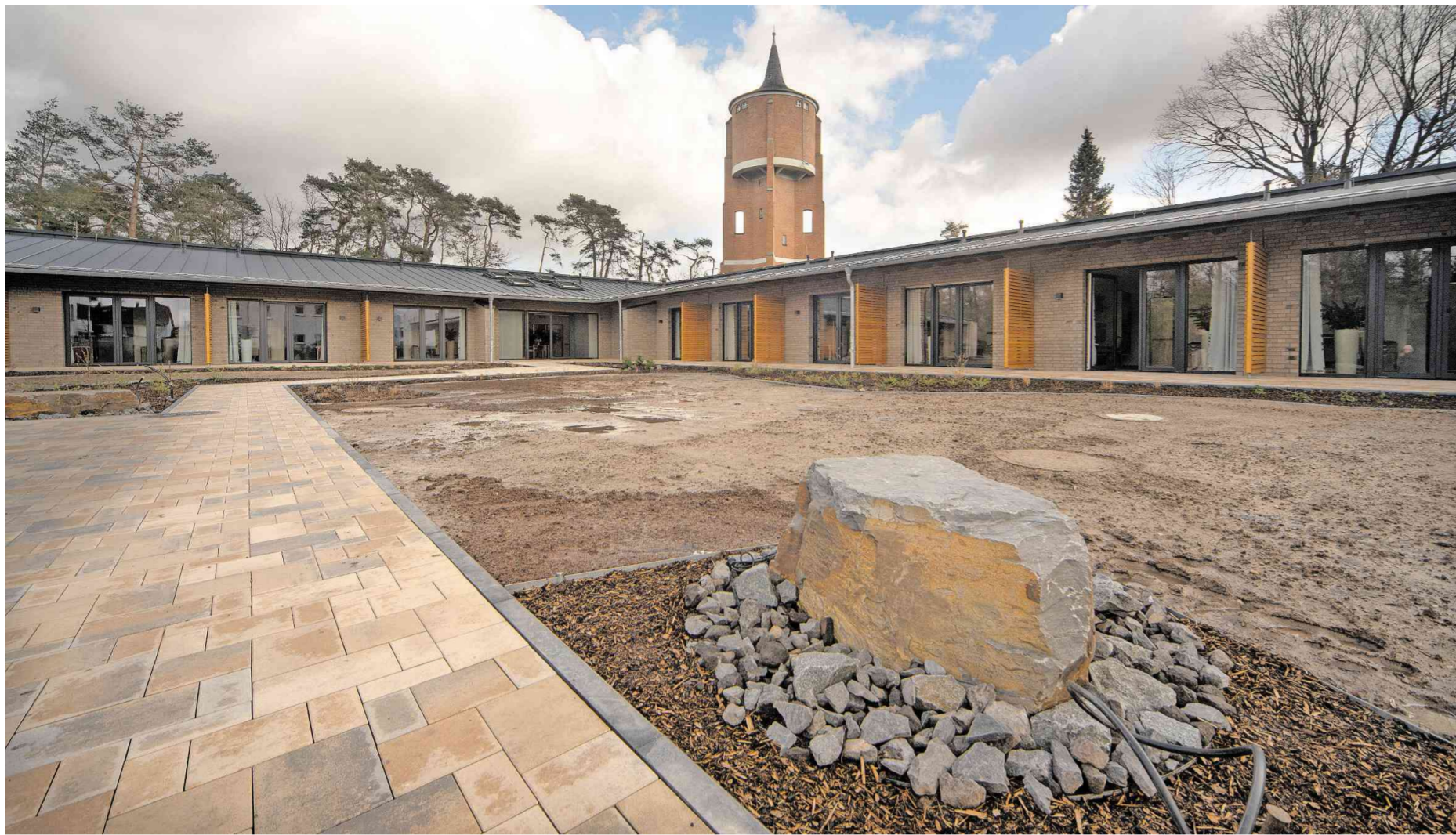
Noch nicht in Betrieb: Brunnenstein im Park am neu errichteten Hospiz am Wasserturm in Rodgau
