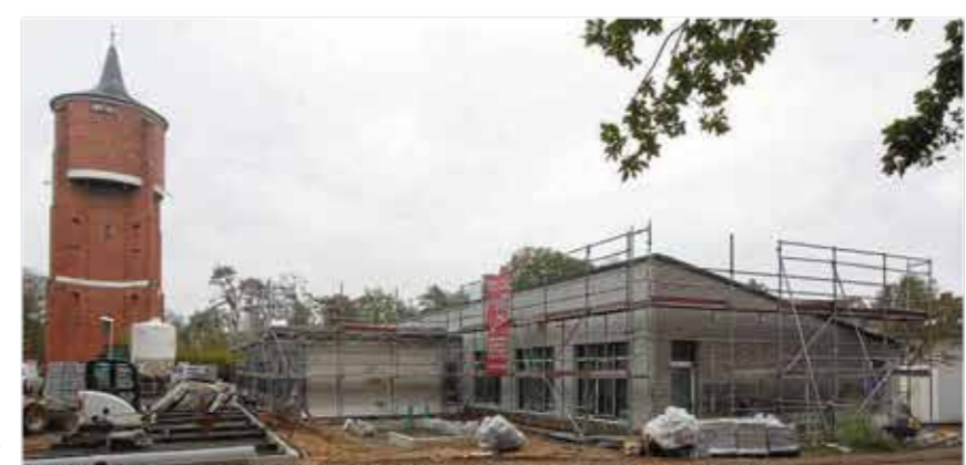
Am Fuß des Wasserturms errichtet die Hospizstiftung Rotary Rodgau das erste stationäre Hospiz im Kreis Offenbach.
